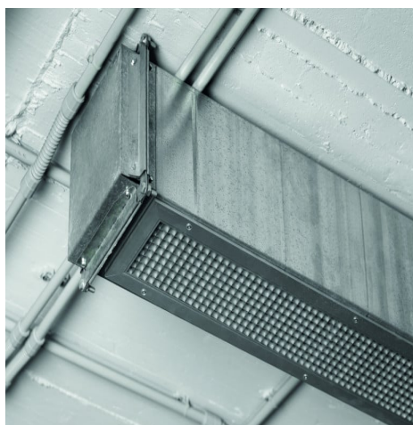
Fijación de estructuras
