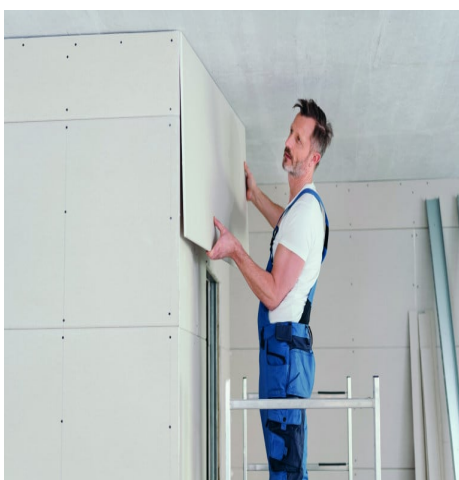
Fijación de placas de yeso laminado
